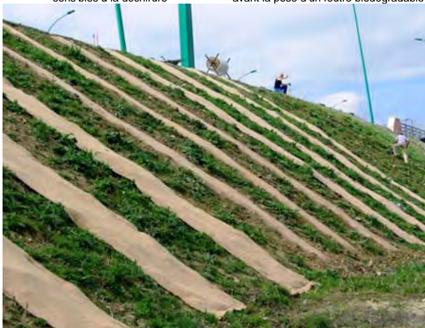
Photo 26 : Sur les paillis posés au sol, les porte-à-faux induits par les dicotylédones augmentent les risques d'arrachement par le vent malgré l'agrafage de surface
