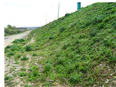
Photo 21 : Avant de pailler un talus, il est indispensable de le désherber
