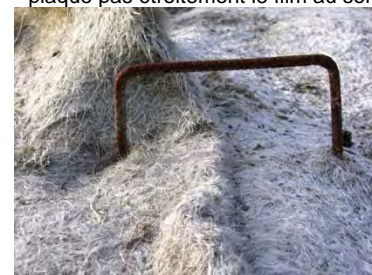
Photo 27 : L'agrafe Picanter sortie du sol n'assure plus le maintien du feutre
