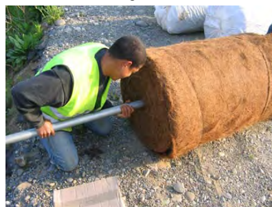
Photo 19 : Introduction difficile d'un axe de déroulage sur un feutre sans mandrin
