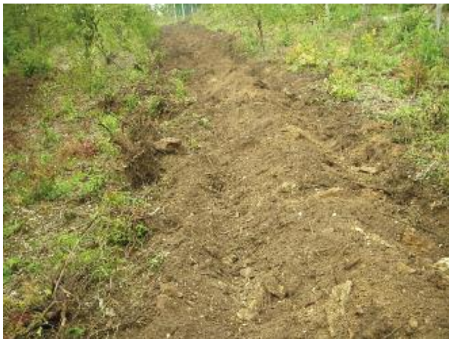
Bande « 3 B » sur friche calcaire avec extraction des pierres et petites souches
